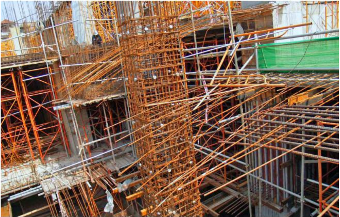
CÔNG TRÌNH NHÀ MÁY NHIỆT ĐIỆN CAO NGẠN
