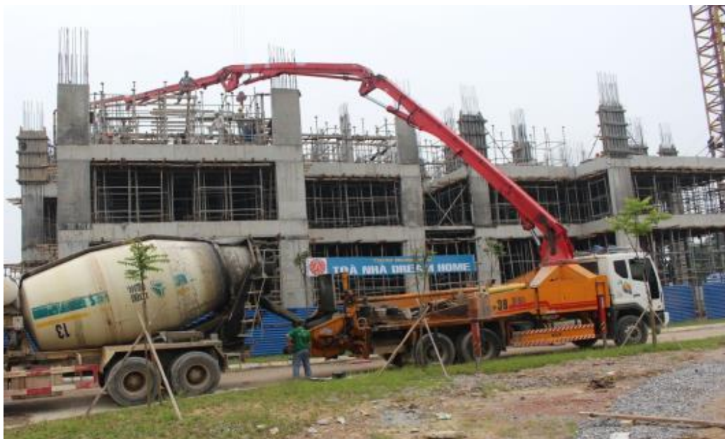
Máy trộn bê tông và cần bơm bê tông
